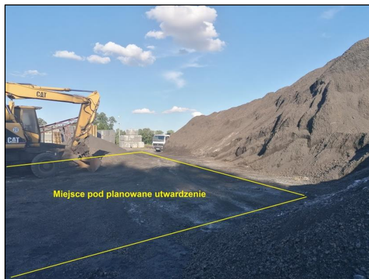
Rysunek 1 Miejsce pod planowane utwardzenie, na którym będą magazynowane odpady o kodzie 10 01 80
