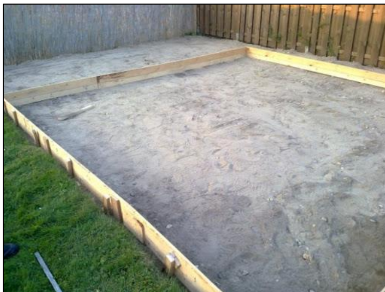
Rysunek 3 Zdjęcie poglądowe szalunku pod wylewkę (źródło: https://www.google.com/images )
