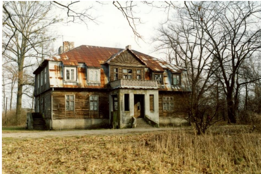
Kamionaczyk – dwór w 2002 r. (fot. M. Urbański)
