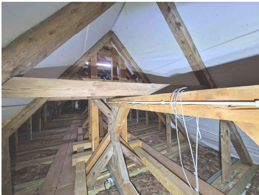
fot. 4. Widok więźby dachowej i stropu nad prezbiterium i nawą (po remoncie przeprowadzonym w 2016 r.) – grudzień 2023 r.
