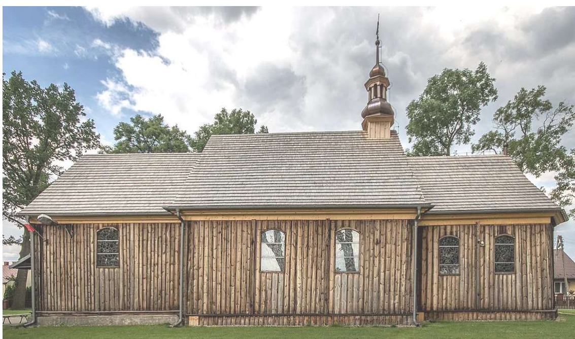
fot. 1. Widok południowej elewacji kościoła po remoncie w 2016 r.
