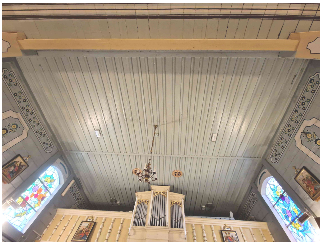
fot. 2. Widok deskowania sklepienia nad nawą (w części przedłużonej od zachodu) - grudzień 2023 r.
