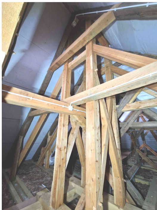
fot. 5. Widok konstrukcji sygnaturki na styku prezbiterium i nawy (po remoncie przeprowadzonym w 2016 r.) – grudzień 2023 r.
