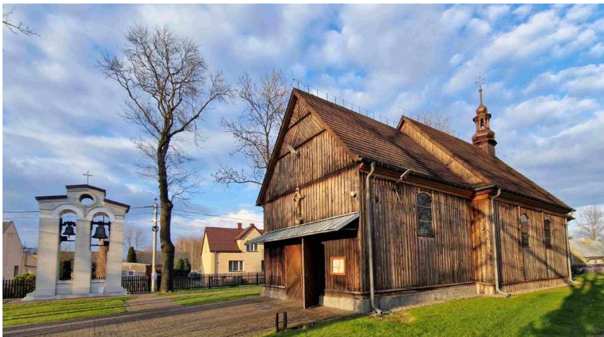
fot. 1. Widok otoczenia kościoła od strony południowo-zachodniej
