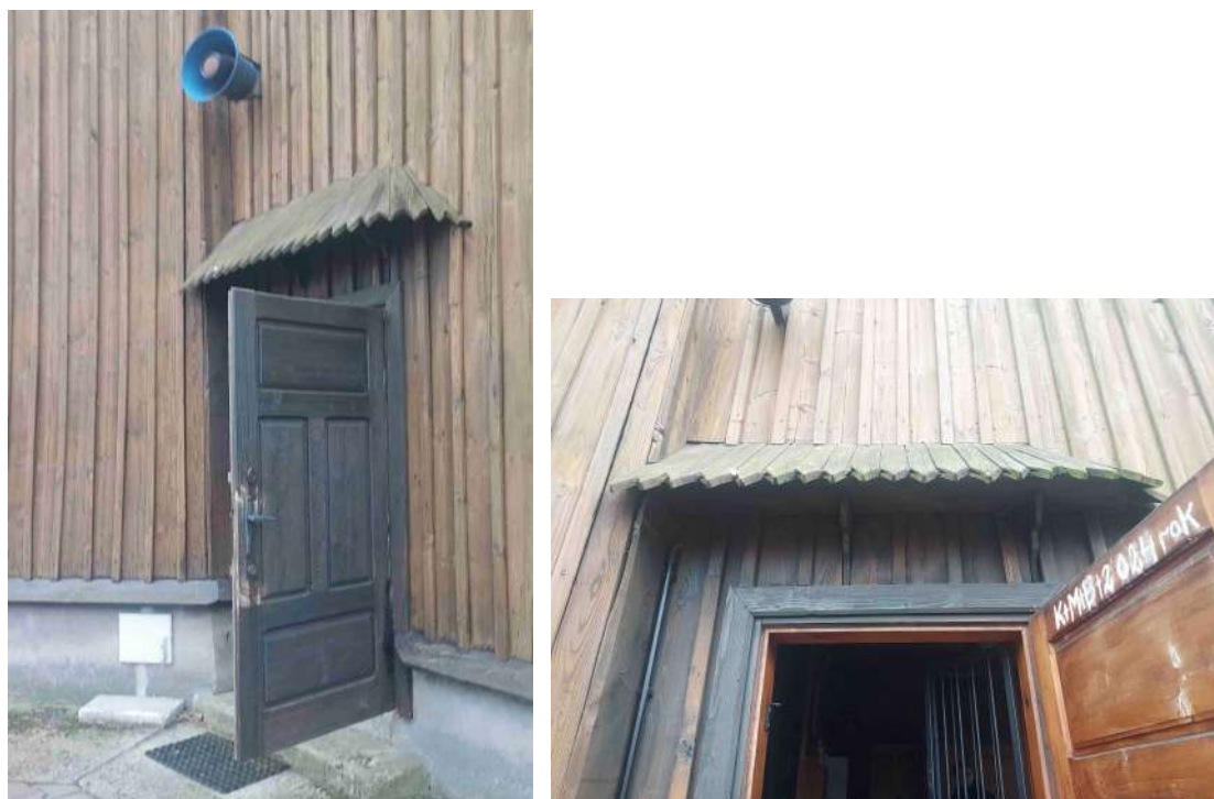
fot. 25. Widok rozwiązania zadaszania w Kościele Parafialnym we Wróblewie na którym wzorowano rozwiązanie projektowe
