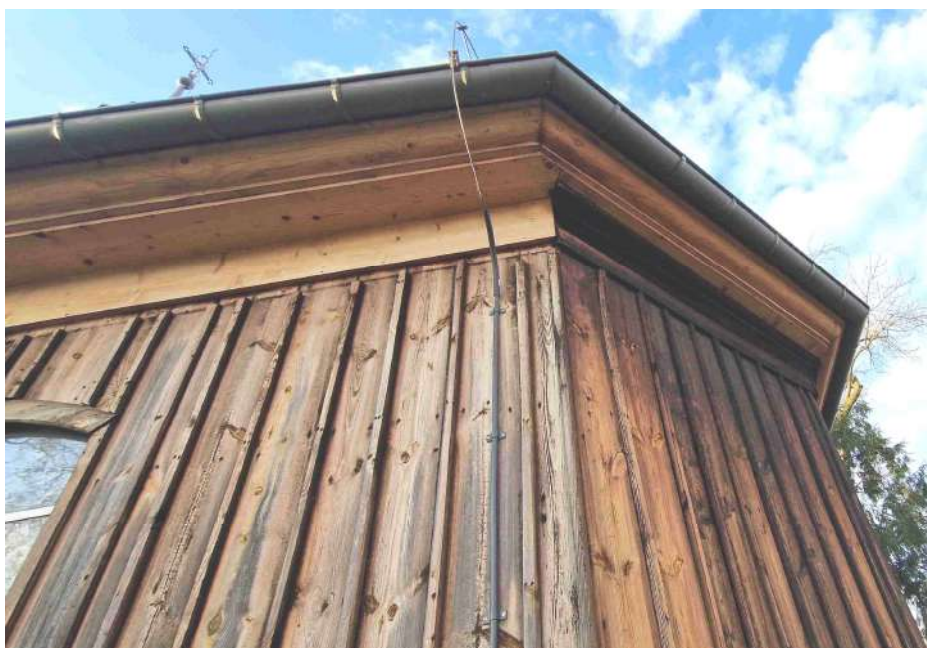
fot. 6. Widok dwupoziomowego gzymsowania w obrębie prezbiterium z poziomymi listwami/deskami maskującymi usunięte deskowanie pionowe
