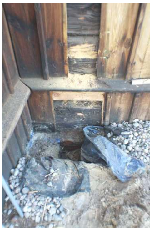
fot. 20. Widok odkrywki fundamentu w strefie prezbiterium – strona południowa
