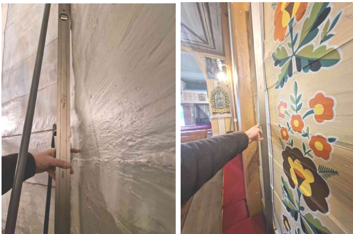
fot. 23. Widok pomiaru wyboczeń/wybrzuszeń ścian pierwotnej i wtórnej nawy oraz prezbitego.
