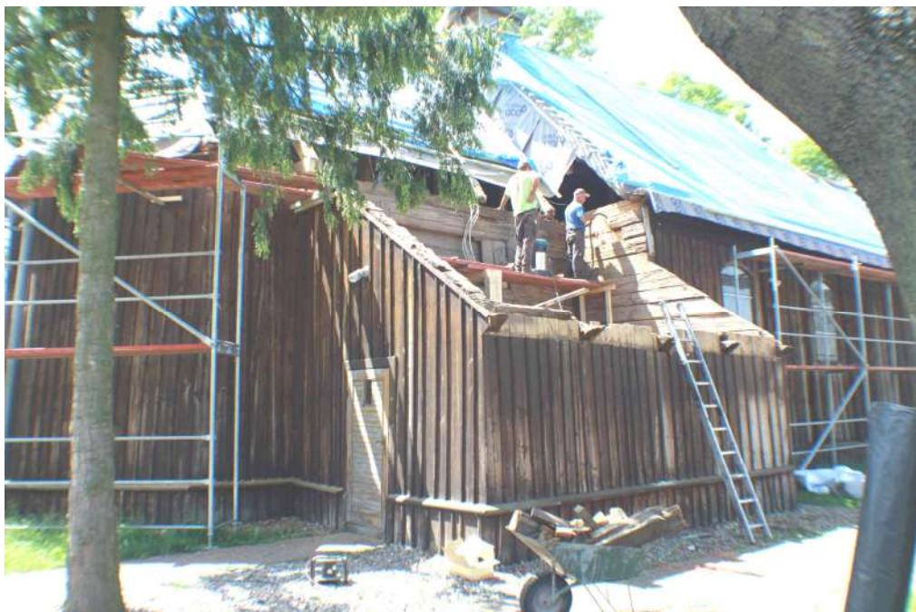
fot. 13. Widok kościoła w trakcie remontu w 2016 r – od strony północno-wschodniej.
