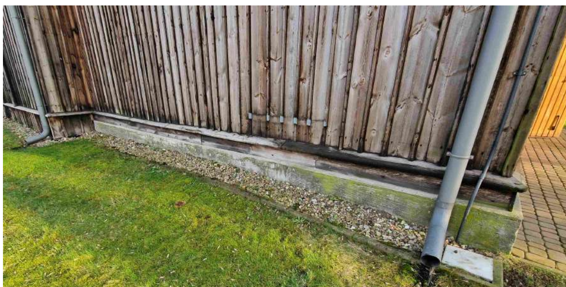
fot. 7. Widok cokołu w obrębie styku obydwu części nawy – strona północna
