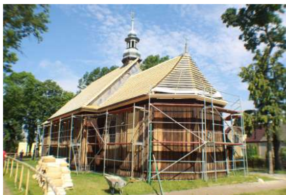
fot. 12. Widok kościoła w trakcie remontu w 2016 r – od strony południowo-wschodniej.
