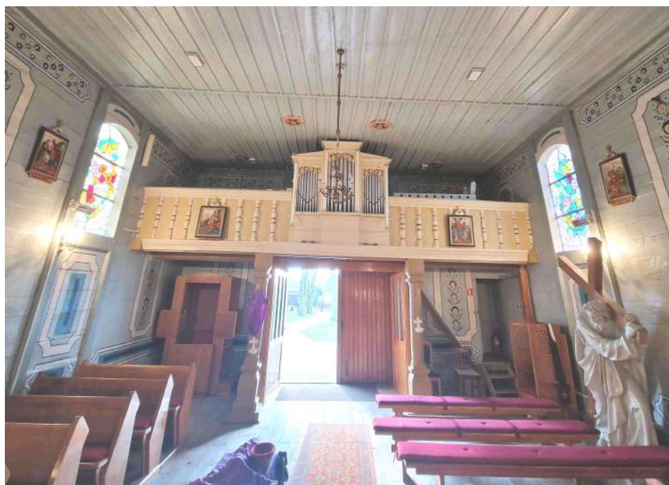
fot. 5. Widok zachodniej ściany szczytowej zamykającej wtórną część nawy z emporą chóru opartą na dwóch kolumnowych, drewnianych słupach
